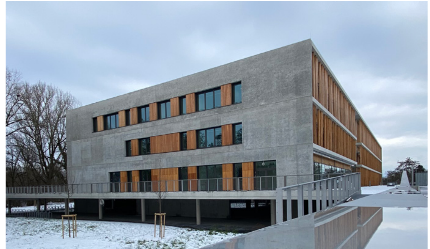
New building „Nachhaltige Chemie“ Uferstraße, Straubing
